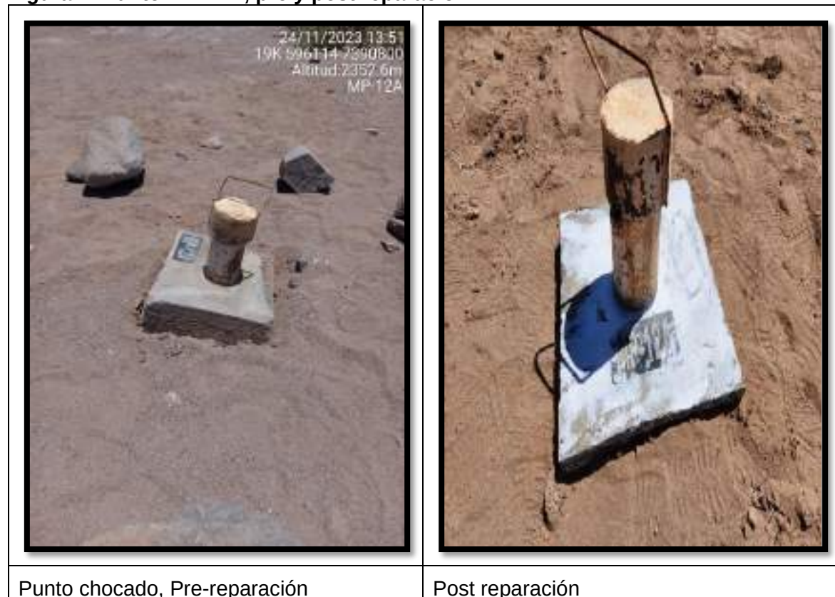
Figura 2: Punto MP-12A, pre y post reparación
