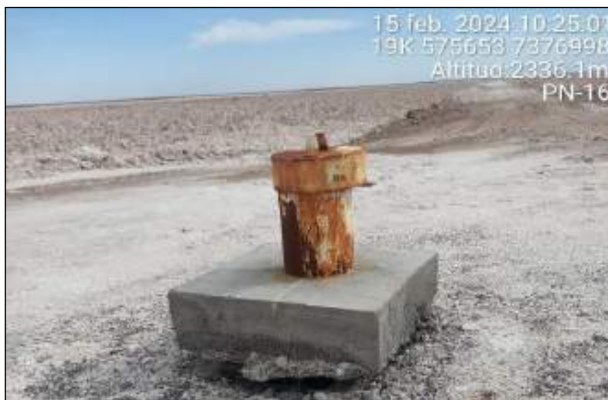
Figura 2: Fotografía del punto PN-16 que muestra la separación entre el sello sanitario y el suelo
