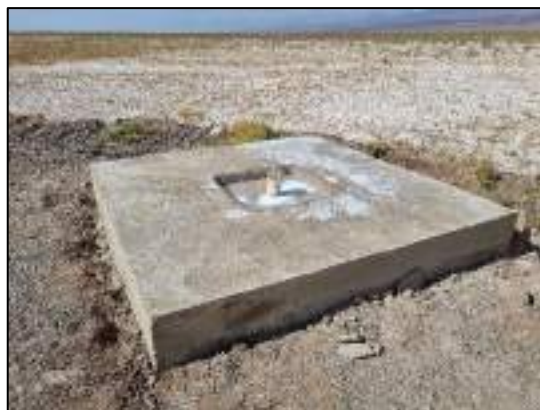
Ilustración 4. Vista de pozo MP-08A post reparaciones
