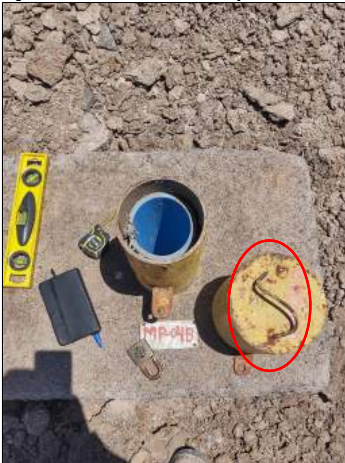
Figura 4: Punto MP-04B con manija averiada
